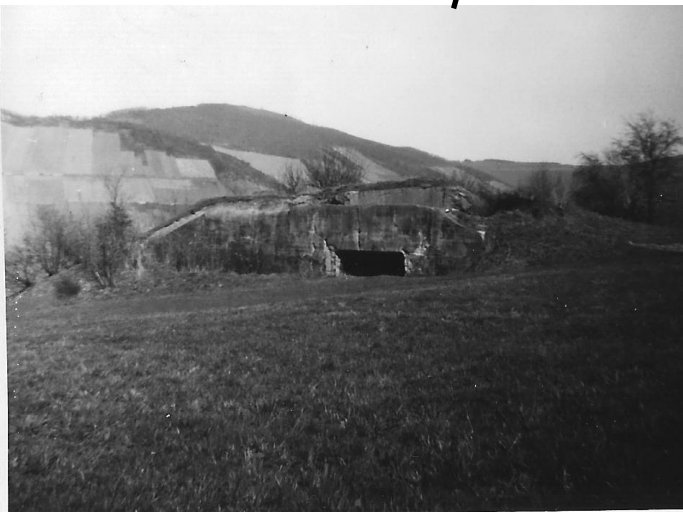
Abb. 11 Igelstellung Ockfen, Bauwerk Nr. 268, Aufnahme vom Frühjahr 1966. MG-Schartenstand mit MG-Kasematte und Sehrohr ohne flankierende Anlage gemäß Regelbau 108 d. © J. K.
