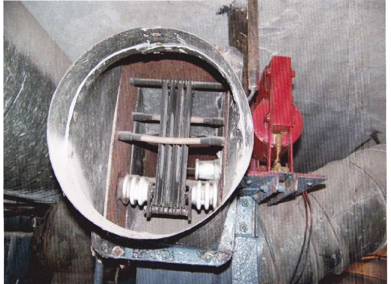
Abb. 10 Einblick in den Ozonerzeuger (Archiv Lambert)
