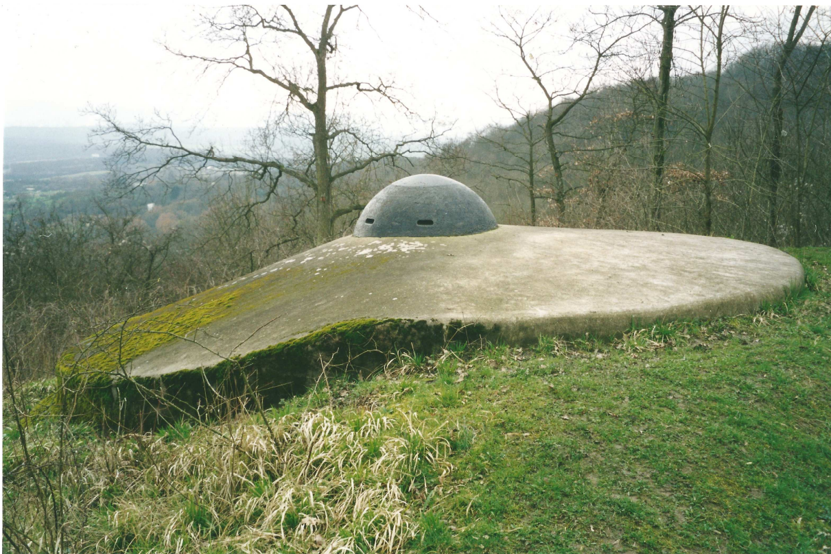
Abb. 4 Bereitschaftsraum mit Wachturm (Archiv Lambert)
