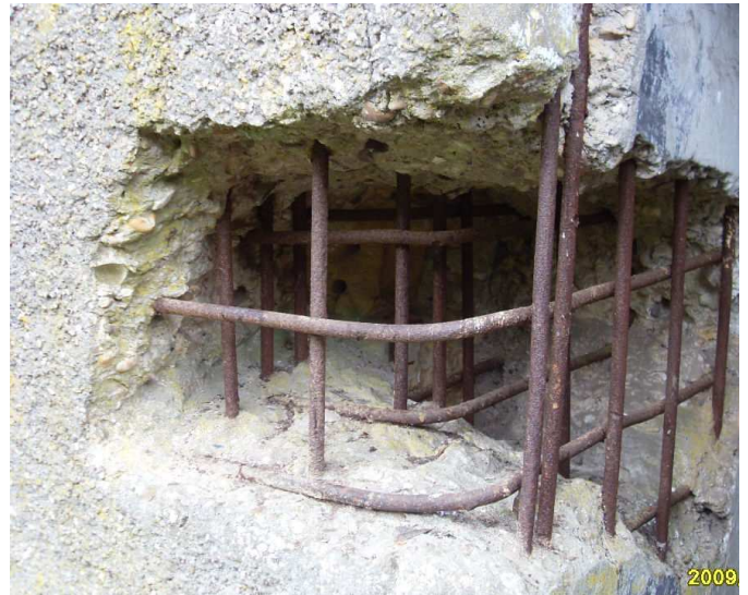
Abb. 7 Verstärkung der Kehlfronten durch Anordnung einer Betonschürze. Hier ein Detail der Glattstahlarmerung
